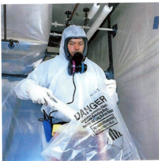
Fig. 15. Respirador purificador de ar motorizado com filtro P3 montado em peça facial inteira. (Cortesia: 3M)
